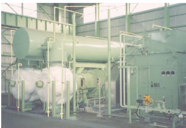
Figure 6. LNG BOG compressor.
